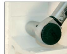
6. Konsole entsprechend den Montagevorschriften des verwendeten Dübels befestigen.
