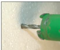
1. Loch in Isolierung bohren.
