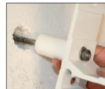
5. Bei Durchsteckmontage: Konsole mit RECA Dimos montieren.
